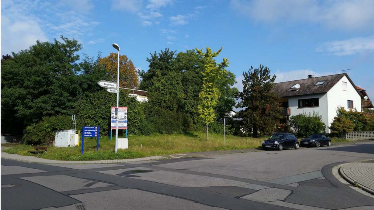
Abb. 4: Südostansicht des Grundstücks
